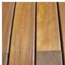
Terrasse traitée avec Cetol WF 771
